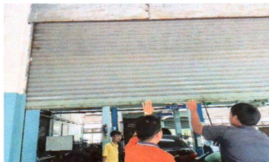
รูปภาพ ปรับปรุงซ่อมแซมซ่อมแซมประตูม้วน อาคารเรียน วิทยาลัยการอาชีพอุทุมพร
