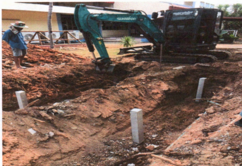
รูปภาพ งานขุดทำคาน วางคาน และกดเสาเข็ม
