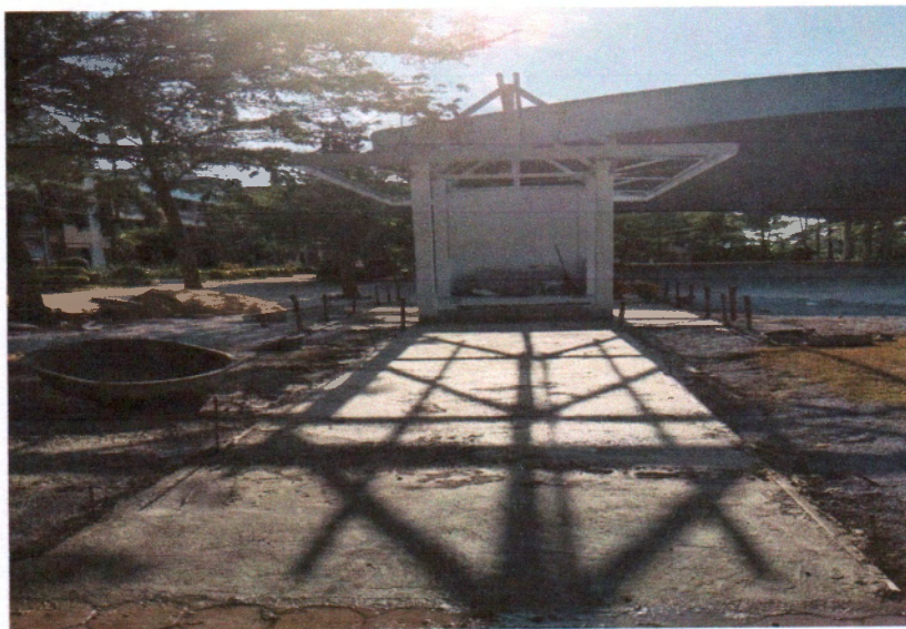
รูปภาพ งานก่อฉาบ ปรับแต่ง และงานเทพื้น
