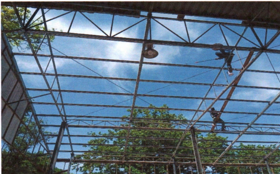
รูปภาพ งานรื้อวัสดุหลังคาและแผงกันเหล็กตัดออกแผนกวิชาช่างก่อสร้าง
