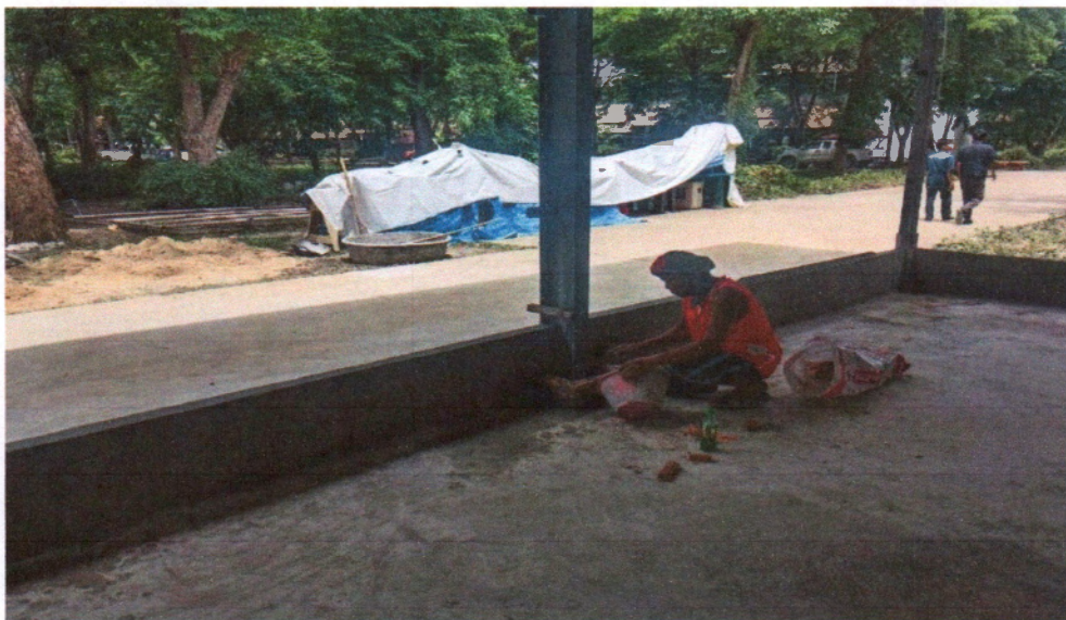
รูปภาพงานก่ออิฐบล็อกจากช่างและงานฉาบ แผนกวิชาช่างก่อสร้าง
